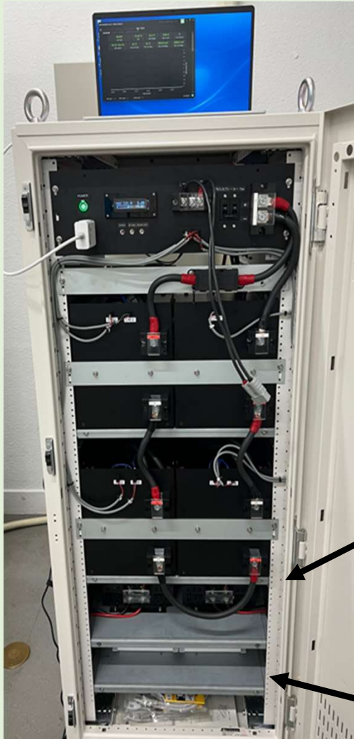
例)E6電池システム
