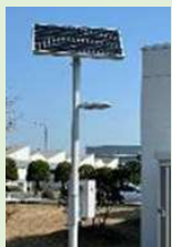
福岡県苅田町
