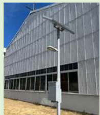
栃木県上三川町
