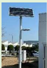
福岡県苅田町
